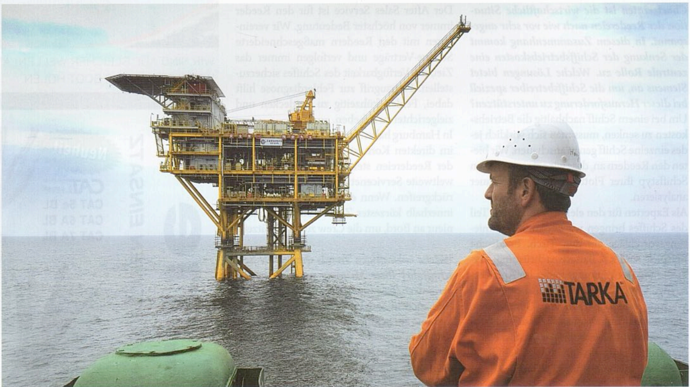
Tarka Systems im Einsatz bei der Installation einer Offshore-Plattform im Chinesischen Meer
